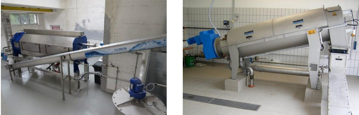
**Abbildung 12: Beispiele einer Schneckenpresse zur stationären Klärschlamm-Entwässerung der Hersteller IEA (links) und Huber (rechts) (Quelle: IEA Derflinger GmbH und Huber SE)**
